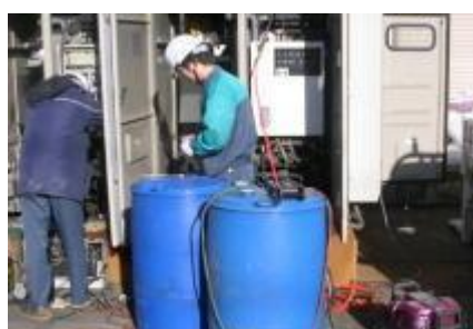
<回収作業の様子>
