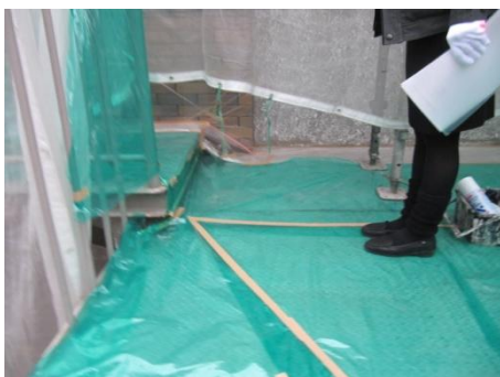
足場の床をビニールで覆う
