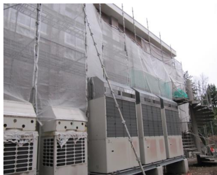
足場をメッシュシートで覆う
